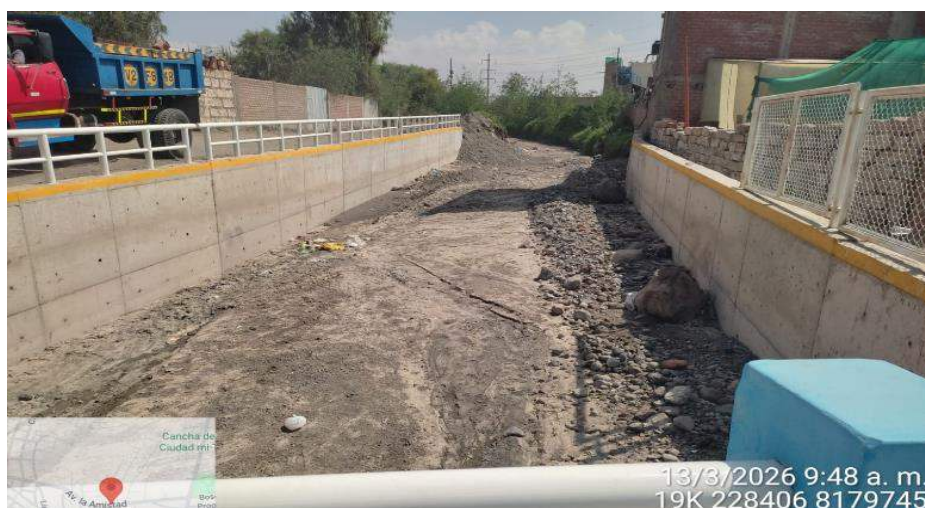
IMAGEN 02: SE OBSERVA EL TRAMO DEL PUENTE DE LA AMISTAD AGUAS ARRIBA COLMATADO MURO DE POCA ALTURA Y FALTA DE CONSTRUCCION DE MURO DE CONCRETO AGUAS ARRIBA
