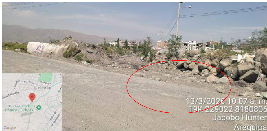
IMAGEN 01: SE OBSERVA EL BADEN DE DONDE INICIA EL TRAMO ASI COMO LA COLMATACION Y LOS BORDOS CON MATERIAL PROPIO PARA INFRAESTRURURA CON MURO DE CONCRETO
