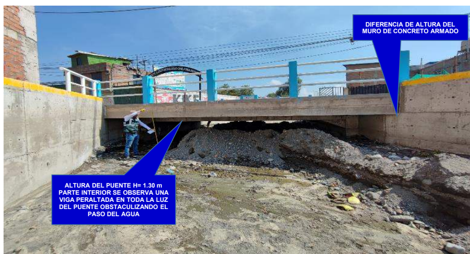
IMAGEN 02: SE OBSERVA LA COLMATACION DEBAJO DEL PUENTE DE LA AMISTAD ASI COMO LA ALTURA DEL PUENTE LA DIFERENCIA DE ALTURA DEL MURO Y EL PUENTE PUNTO EN DONDE UNA MAXIMA AVENIDA OBSTRUIRA EL PASO DEL AGUA DESBORDANDOSE POR AMBAS MARGENES AFECTANDO VIVIENDAS, POBLACION Y AREAS DE CULTIVO AGUAS ABAJO
